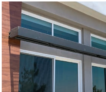
A-1 METAL AWNING
